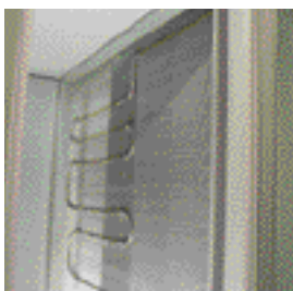
Компоновка для термостата защиты от замерзания
