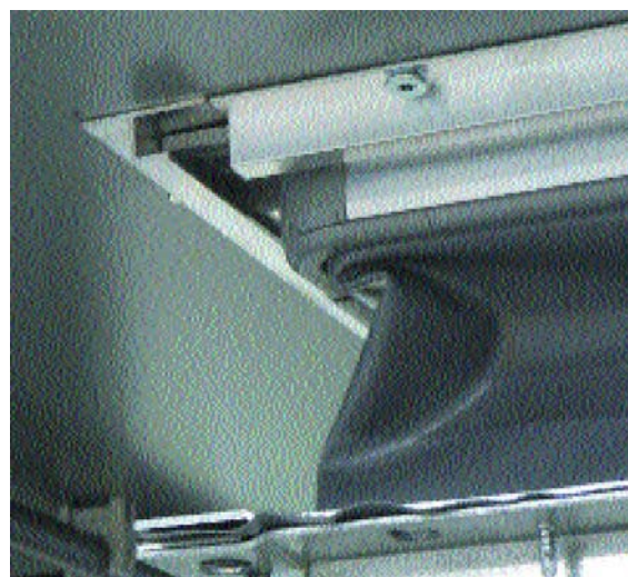
Узел гибкого соединения вентилятора
