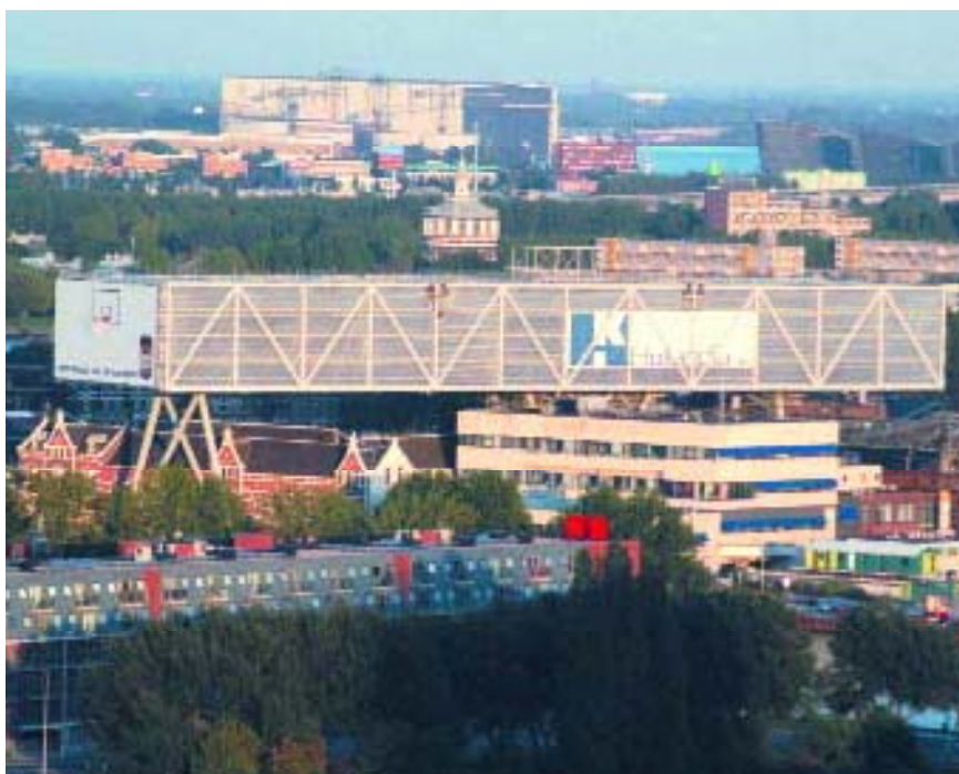
Kantoorgebouw Unilever "De Brug", Роттердам (Нидерланды)
