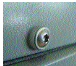
Винт из нержавеющей стали с пластиковым уплотнением
